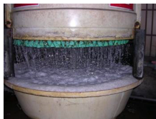
汙水處理系統維修
