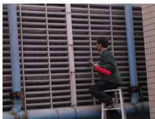
冷氣設備檢修
